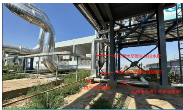
有压雨水替代工业水改造
