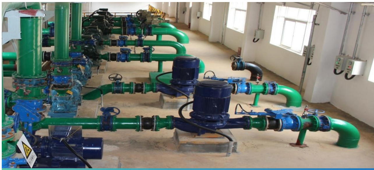
铅熔炼循环水泵
