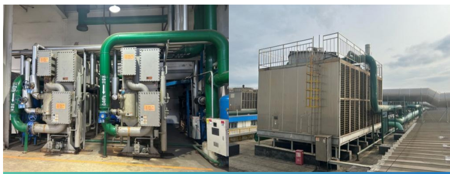
溴化锂制冷机及冷凝水回收
