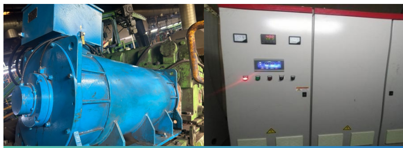
永磁电机控制柜及压出永磁电机
