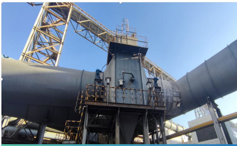
电解槽高温烟气余热回收
