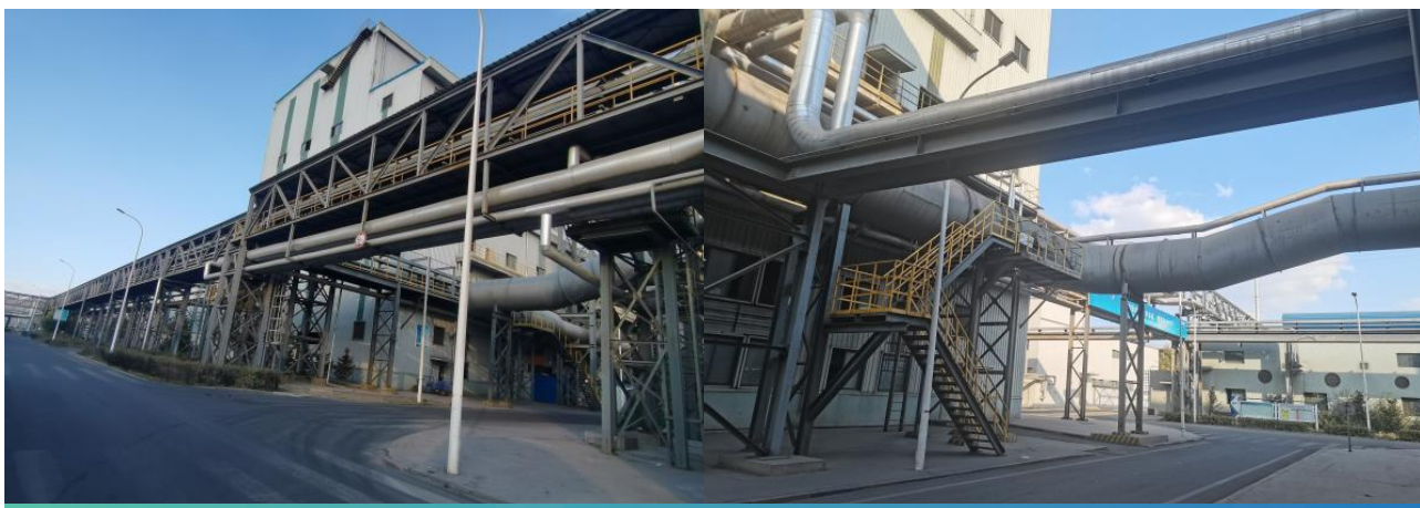
余热产蒸汽 (对内外供汽管道)
