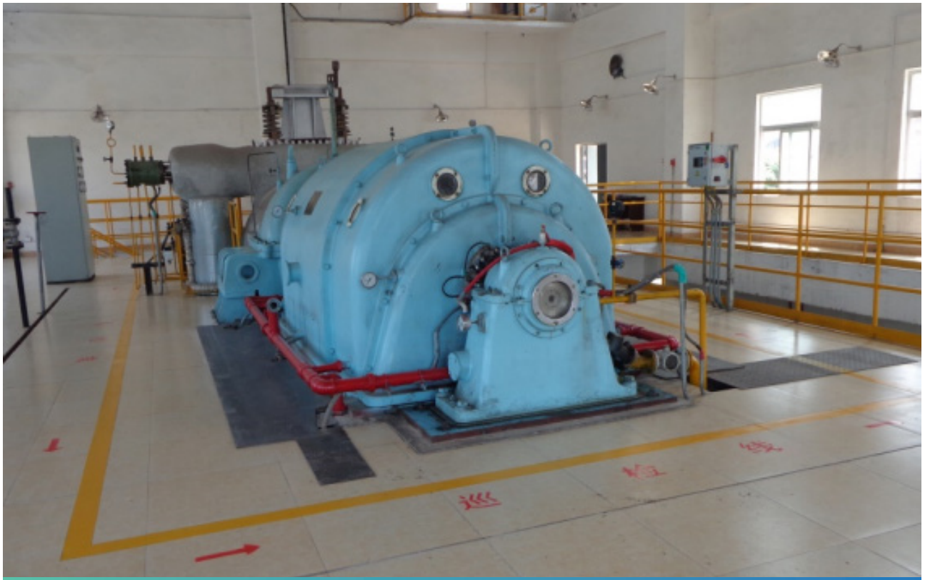
余热发电汽轮发电机
