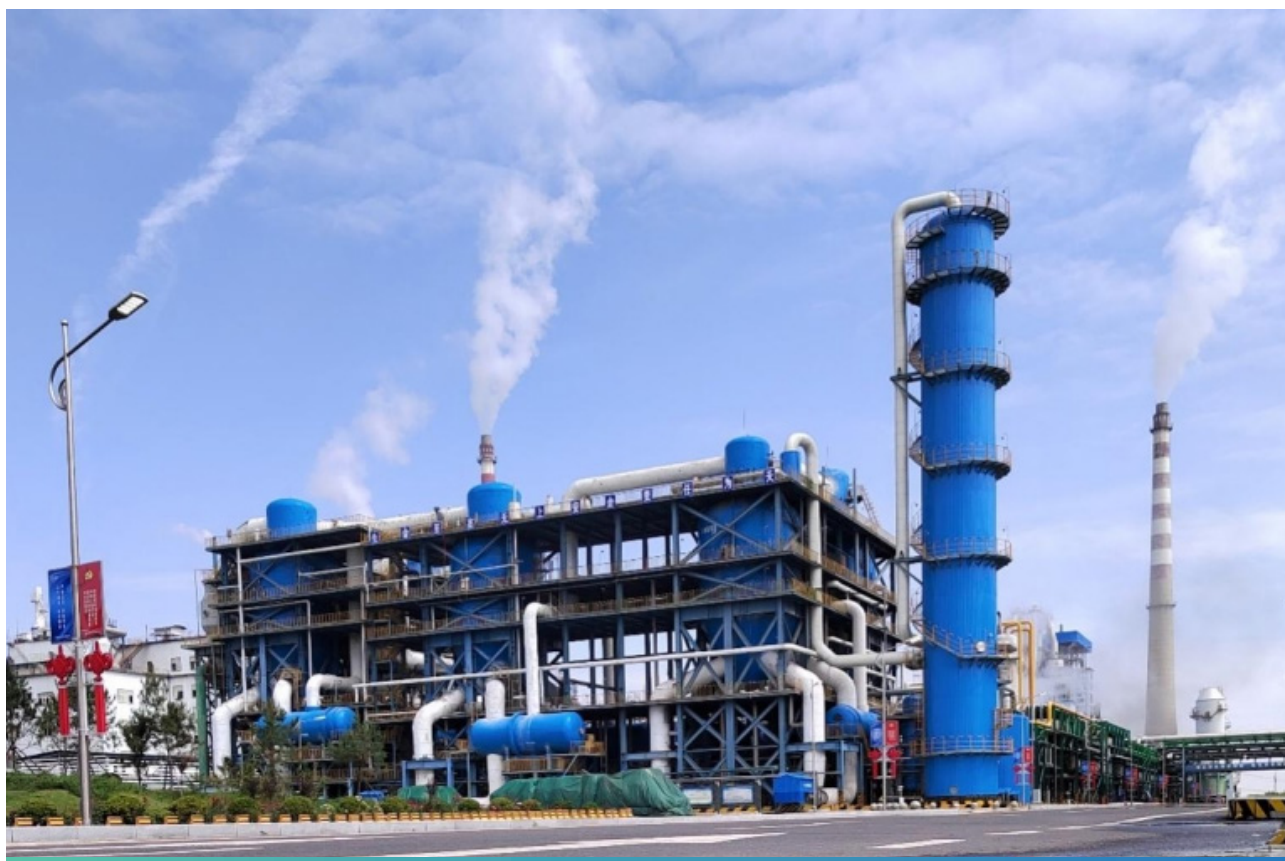
具有湿分解功能的多效真空蒸发结晶器
