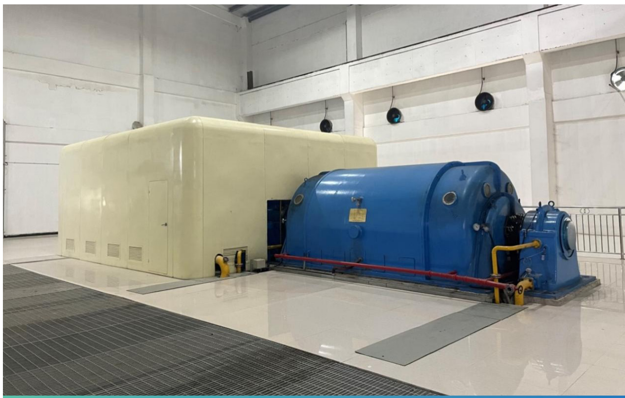
余热发电系统 - 汽轮机
