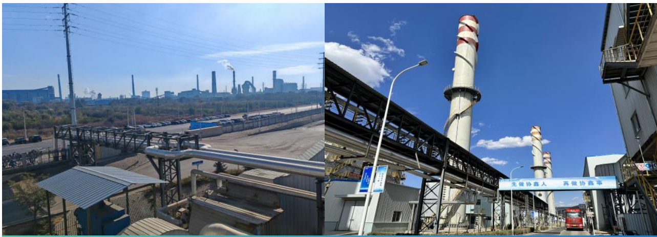
尾部烟气余热利用 (对内外供汽管道)
