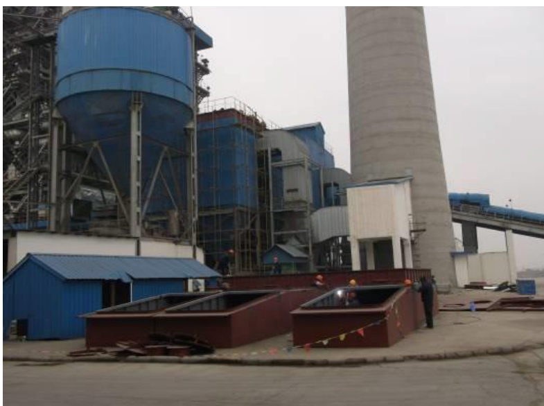
附图 5：山东 2 × 75 t/h 循环流化床锅炉调研照片
