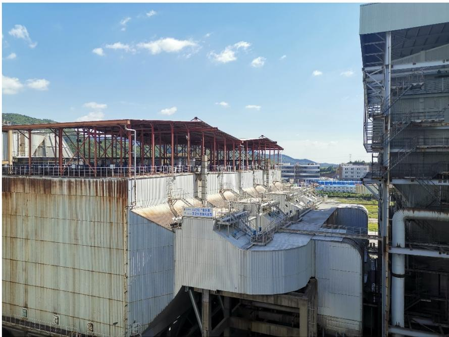
项目于 2020 年 10 月正式开工，2020 年 12 月 16 日顺利投运并通过竣工验收。项目将原有的 4 台低温省煤器换热元件拆除更换为真空热管换热装置，每台真空热管换热装置安装于对应电除尘入口烟道处。
